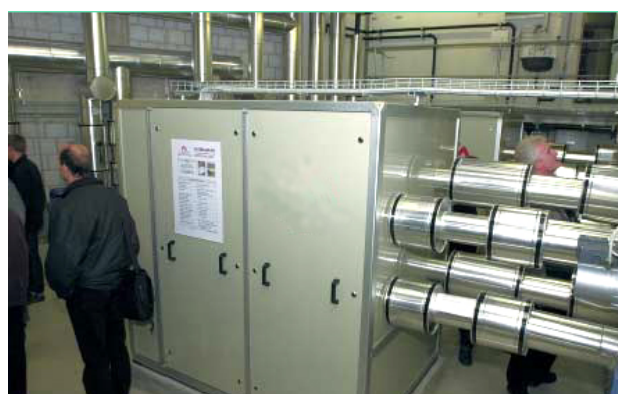
Modèle de pompe à chaleur d'une puissance thermique de 264 kilowatts qui puise son énergie dans le sol au moyen d'un réseau de sondes géothermiques.
