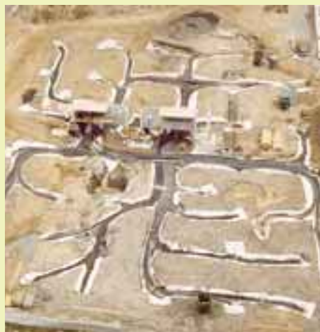
En 2001, 49 sondes ont été introduites dans le sous-sol rocheux, à la distance de 6,5 m les unes des autres. (Photo : D4center.ch)
