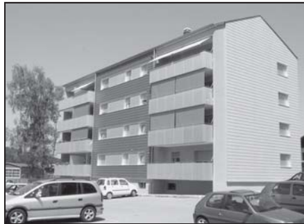
Bâtiment similaire rénové, (FR)
