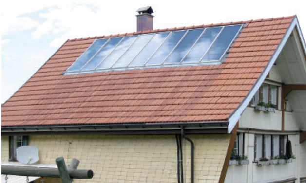
Diviser par deux la consommation d'énergie : les capteurs d'eau chaude divisent par deux la consommation d'électricité et les émissions de CO 2 .
