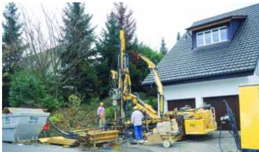
Machine de forage pour sonde géothermique en pleine action.
