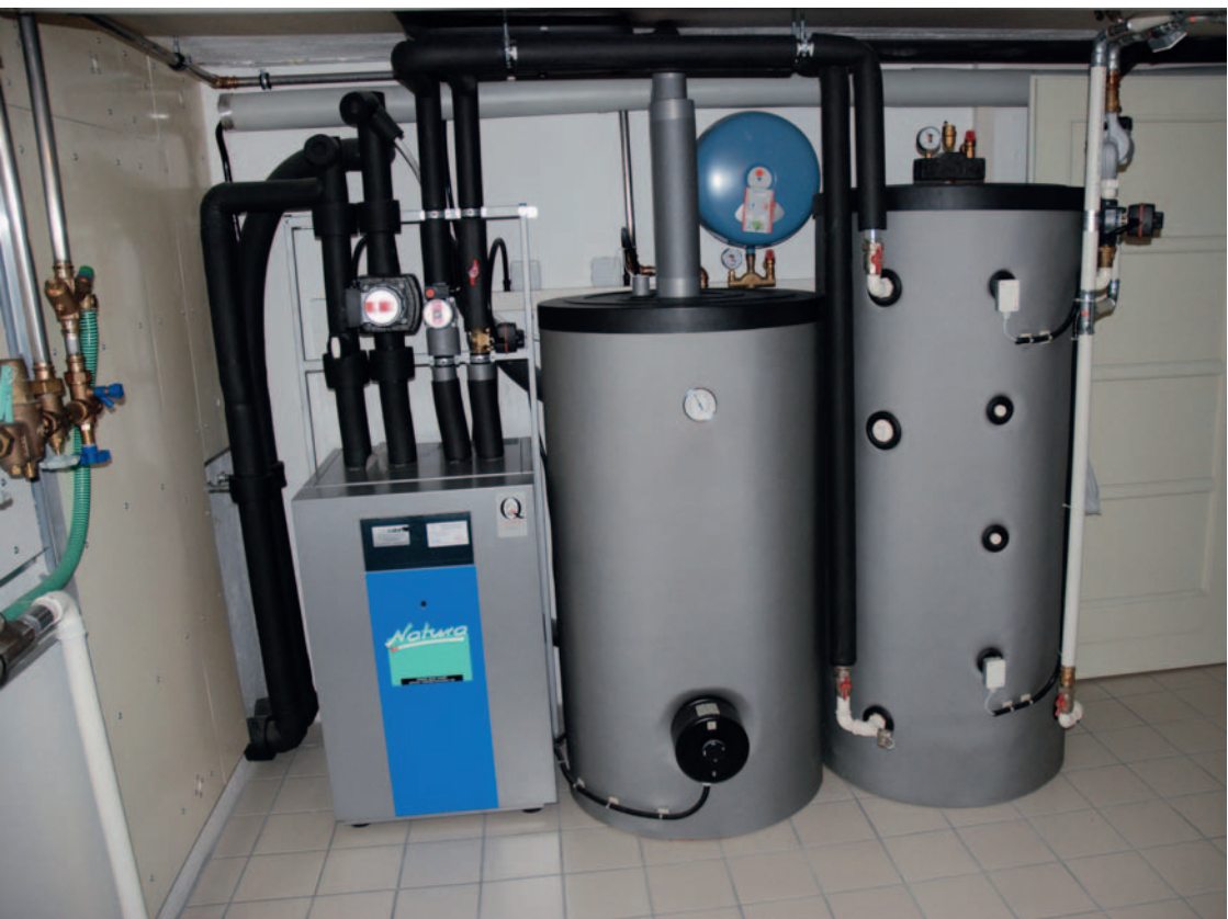
Installation de la pompe à chaleur.
