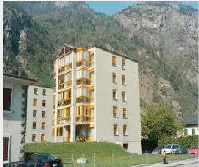
PAC eau-eau, SATAG WW240, 52 kW chauffage, Tour-de-Trême, installateur Umberto Bestazzoni, Martigny
