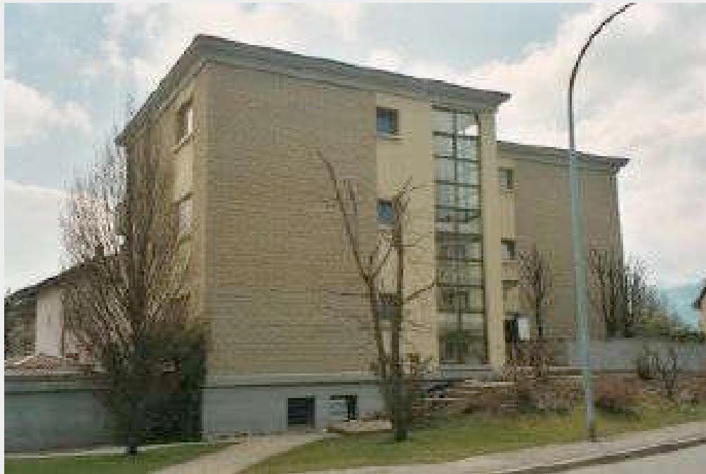
PAC sol-eau, modèle SATAG BW226, 60 kW chauffage, Tour-de-Trême, installateur Gremion&Staremborg SA, Epagny
