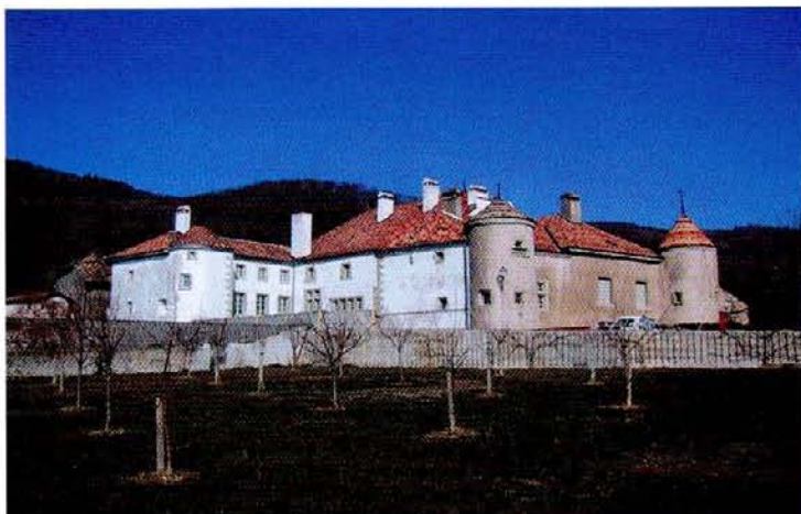
Château Le Rosey à Bursins : mariage réussi entre patrimoine et technologie.
