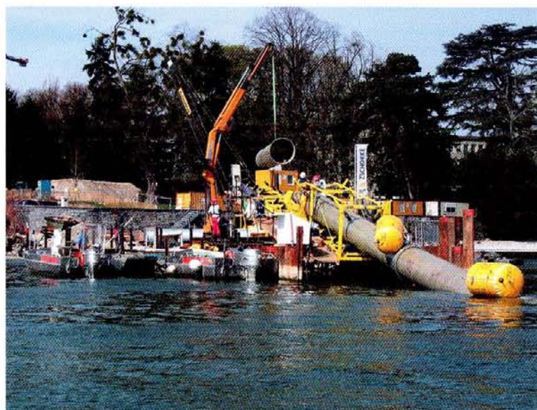
III. 5: Pose de la prise d'eau.
