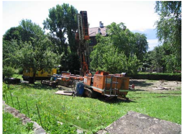
Foreuse pour sonde géothermique en pleine action
