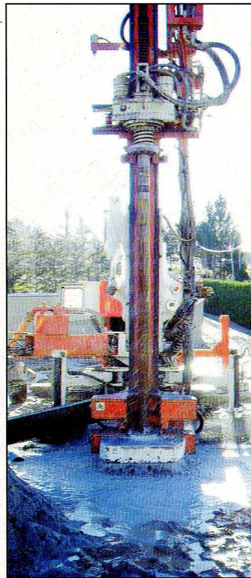
Forage pour une sonde géothermique: «Vous pouvez installer des sondes tous les dix mètres, vous ne prélèverez qu'une partie infime du pouvoir calorifique de la terre.» DR
