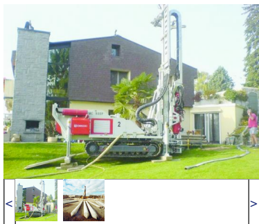
DANS LE JARDIN La taille relativement modeste des foreuses permet la pose d'une sonde géothermique verticale jusqu'à la profondeur de 120 mètres. (SP)
