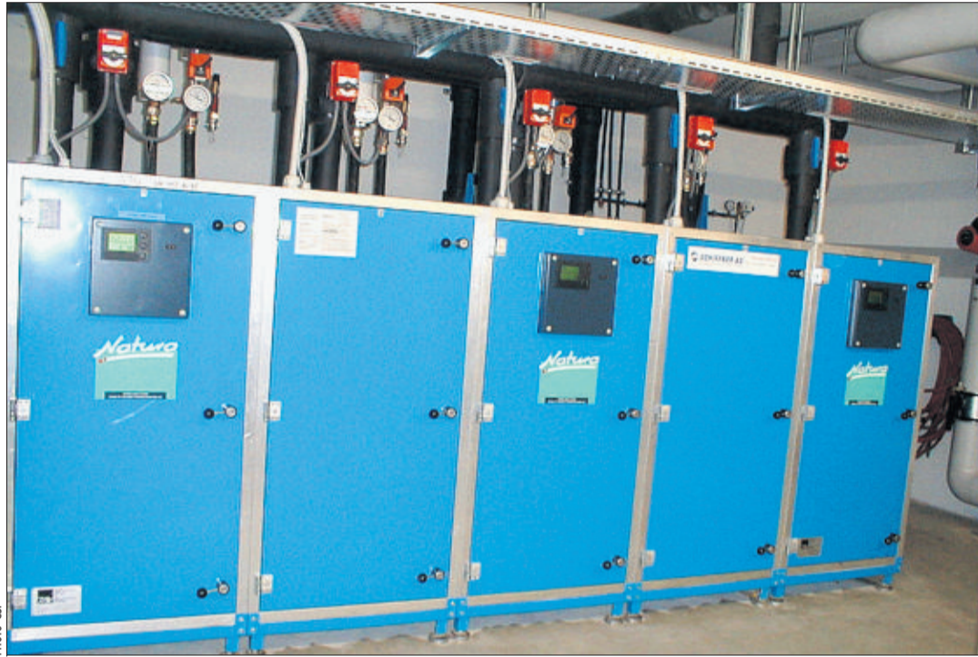
DISPOSITIF La pompe à chaleur est une machine qui permet de produire de la chaleur en majeure partie d'origine renouvelable et sans dégagement local de CO 2 .
