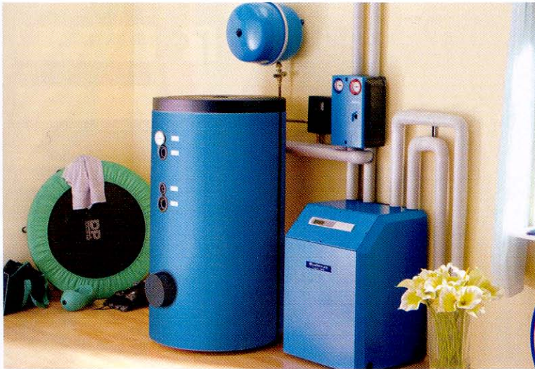
Pompe à chaleur sol/eau.
